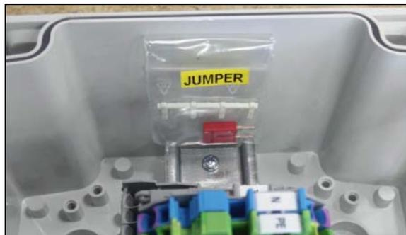
Перемычка и заглушка в электромонтажной коробке
